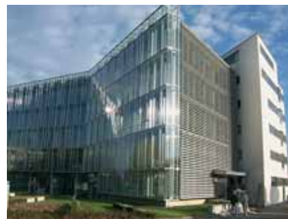
A Raiffeisen Bank irodaháza, hazánk harmadik legnagyobb geotermikus hőszivattyús referenciája
