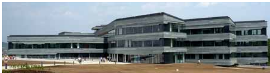
Magyarország második legnagyobb geotermikus hőszivattyús referenciája, a Pannon GSM irodaház
