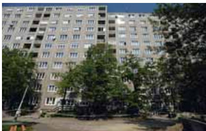
A Hun utcai panelépület, hazánk legnagyobb geotermikus hőszivattyús referenciája
